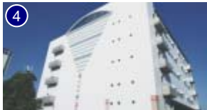
M-4 東京新木場物流センター
